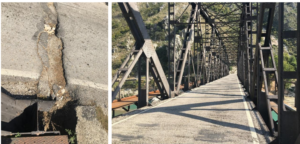
Figura 10 Mungesa e plotë e punimeve të mirëmbajtjes rutinë, bllokimi i fugave.
