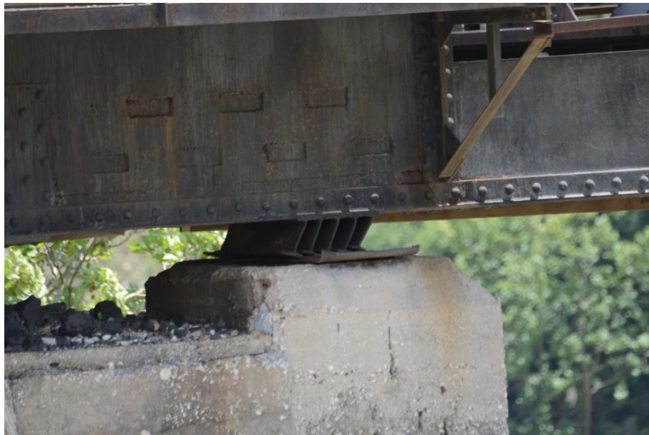
Figura 13 Mbështetje provizore ndërhyrja e vitit 1957
