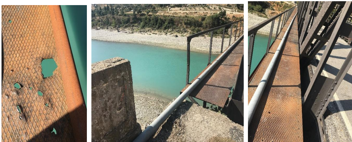
Figura 10 Mungesa e plotë e punimeve të mirëmbajtjes rutinë, bllokimi i fugave.
