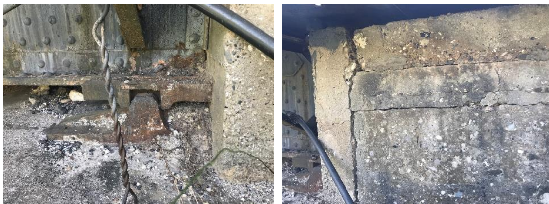
Figura 8 Çernierat në ballin nga Dragotit
