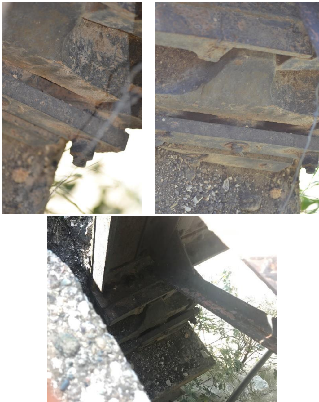
Figura 7 Çernierat në ballin nga Tepelena
