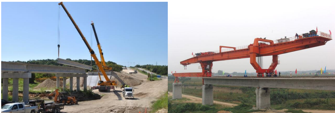
Figura 3: Vendosja e trarëve në vepër për lartësi pile <20.00\text{m} dhe > 20\text{m}
