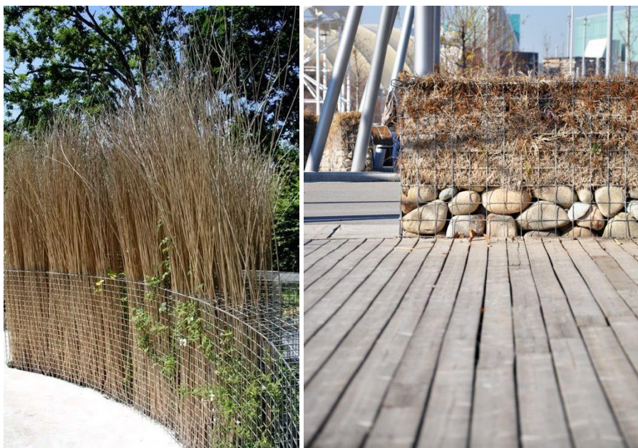
Figura 41 Shembull i Murit të Gabionit
