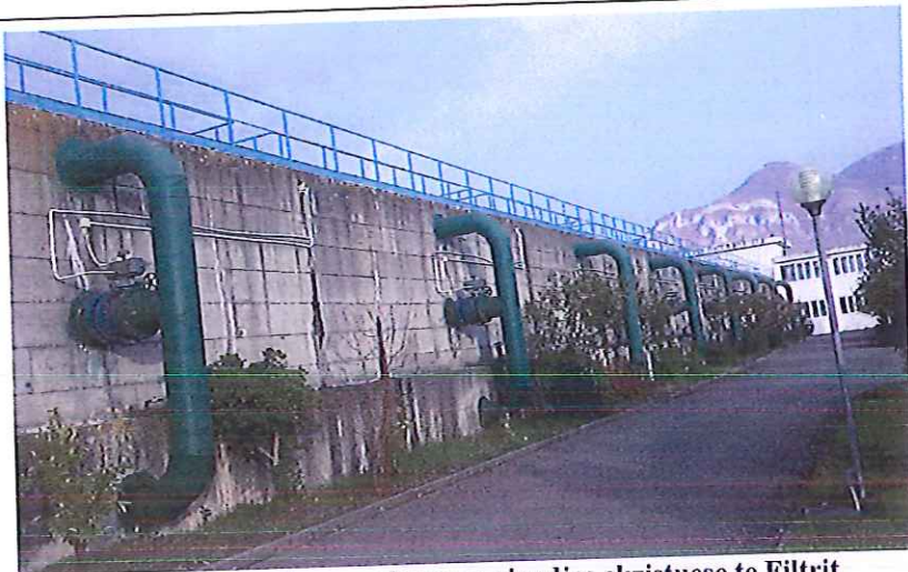
Figure 55, Pamje nga mbrapa e gjendjes ekzistuese te Filtrit
