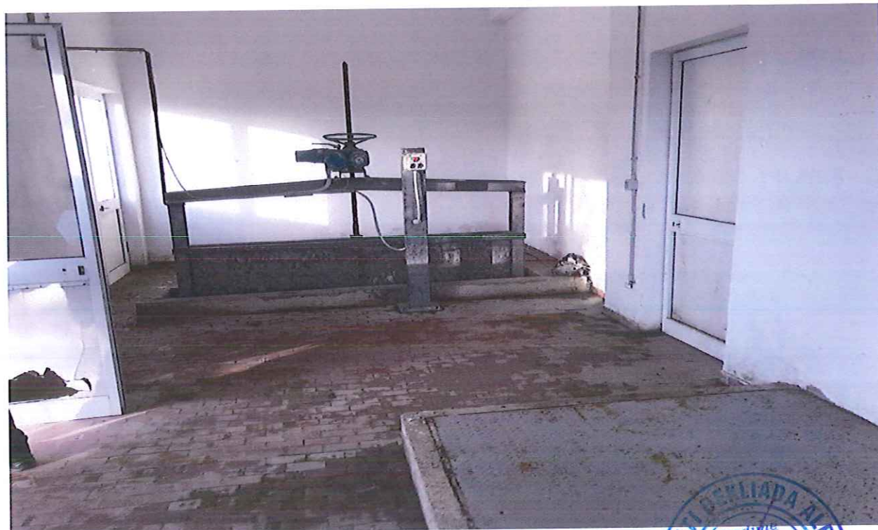
Figure 20, Pamje e portes teknologjike ekzistuese ne ambientet e manovrave
