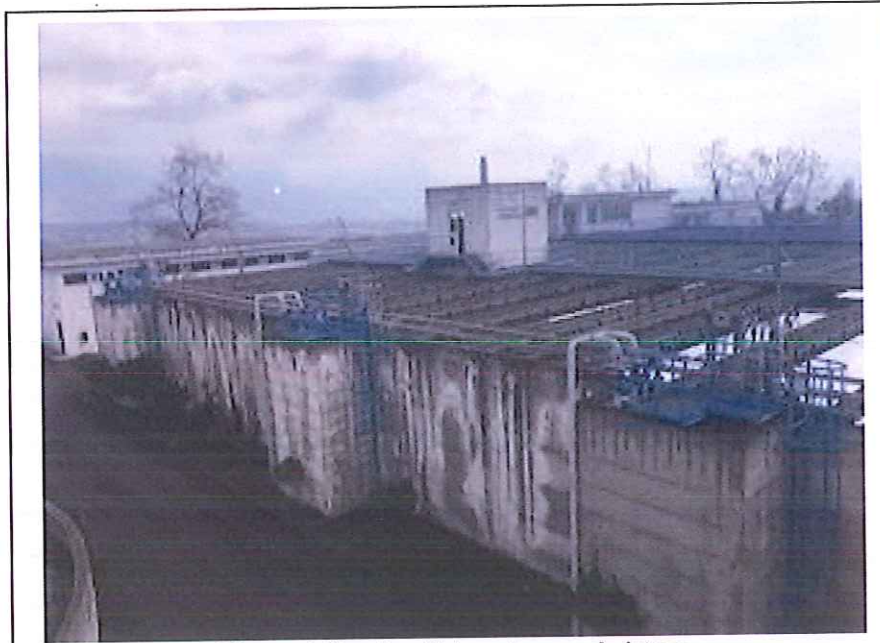
Figure 4, Pamje e flokuratoreve ekzistues
