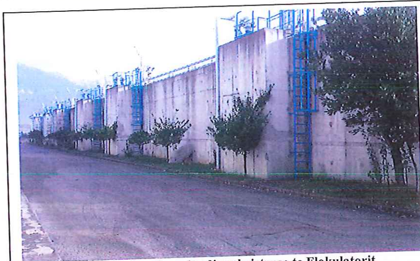
Figure 51, Pamje e gjendjes ekzistuese te Flokulatorit
