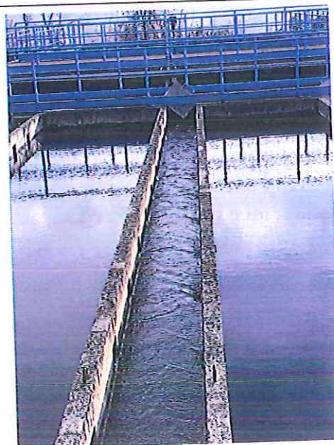
Figure 53, Pamje e gjendjes ekzistuese te Flokulatorit
