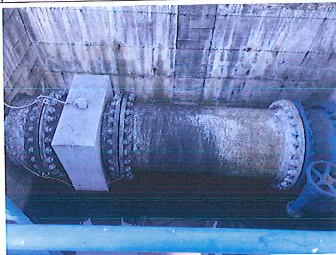
Figure 1, Pamje e pusetes ekzistuese te matesit elektromagnetik
