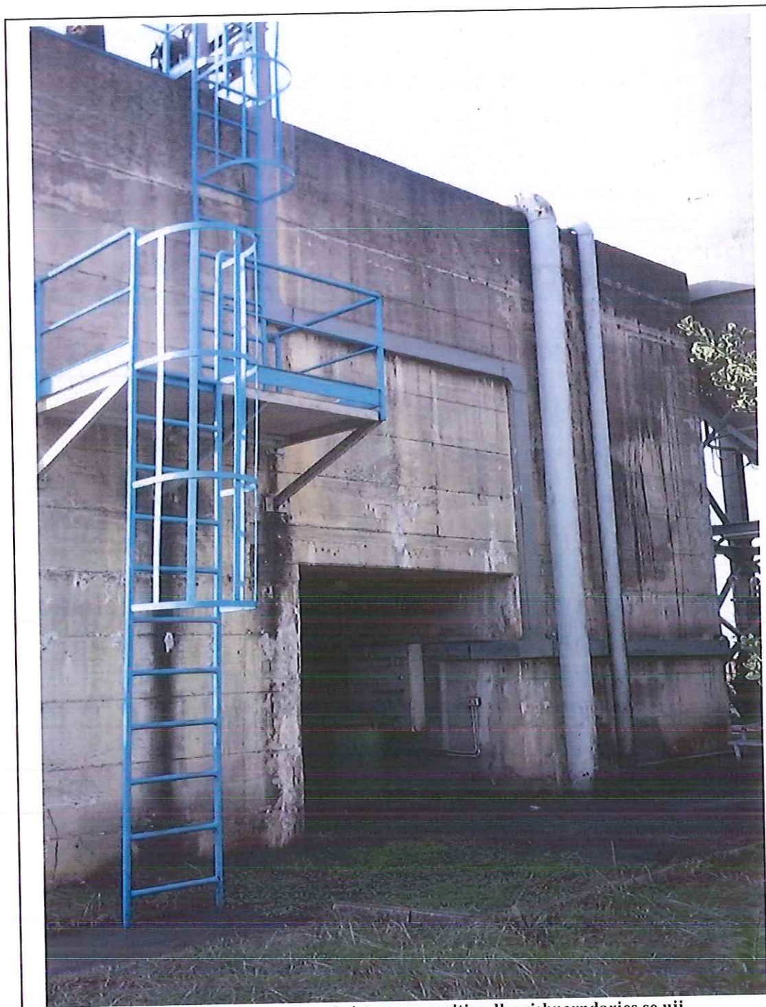
Figure 2, Pamje e vaskes ekzistuese se arritjes dhe rishperndarjes se uji
