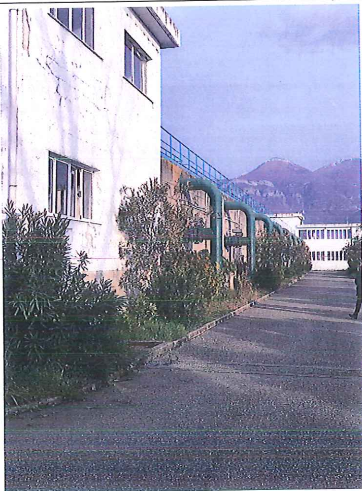
Figure 70, Pamje e gjendjes ekzistuese e ambienteve te sherbimeve (tek filtri)
