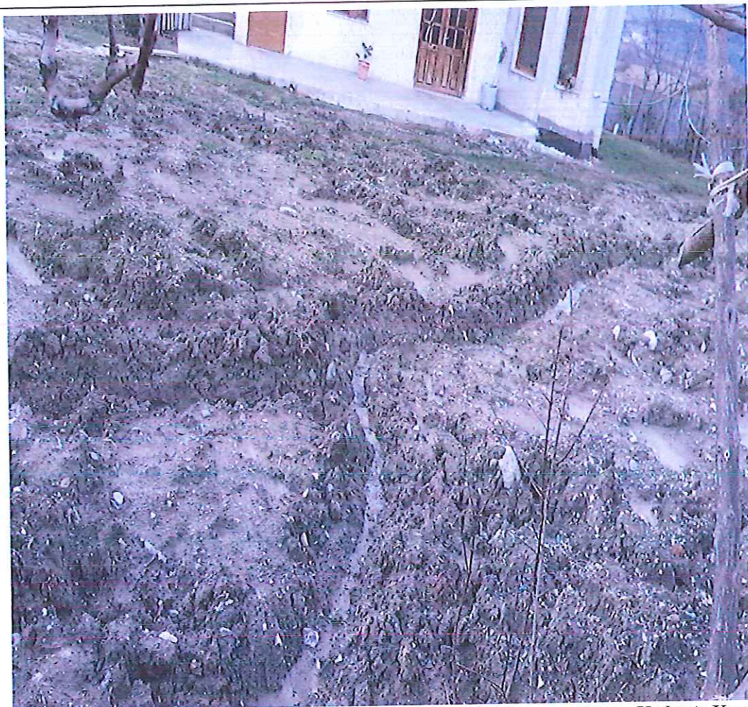
Figure 41, Pamje e humbjes permanente të ujit në tubin DN 900 mm çeliku në Koder të Kuqe
