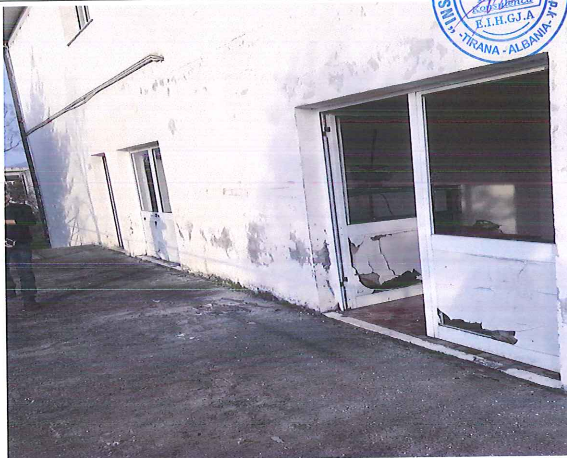
Figure 21, Pamje e ambienteve ekzistuese te manovrave dhe kontrollit dhe dhomave te sherbimit
