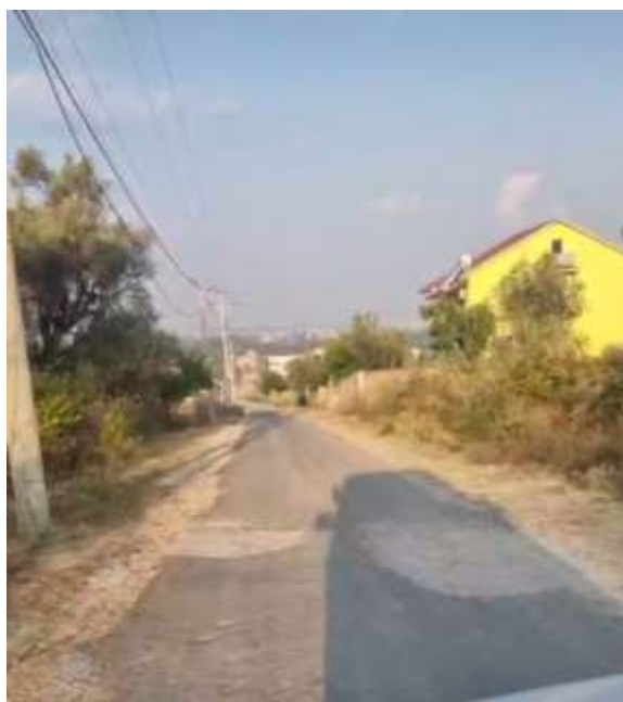
Figure 1 Gjendja ekzistuese nga km0 +340m
