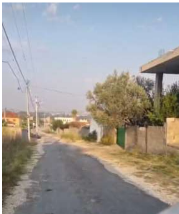
Figure 2 Gjendja ekzistuese nga km0 +340m
